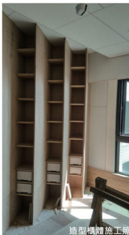
造型櫃體施工照
