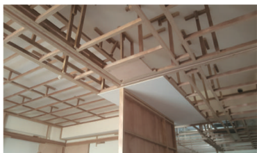
3IN綠能角材現場施工照
